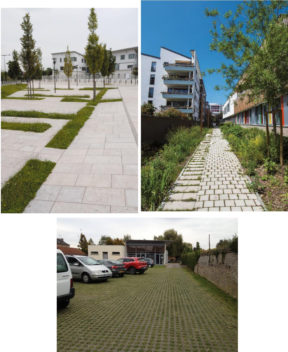
Figure 7 : Exemples d'aménagements limitant l'imperméabilisation
