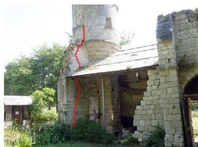
9 - Repérage de la fissure en forme de S affectant le parement intérieur du pignon Nord du bâtiment
