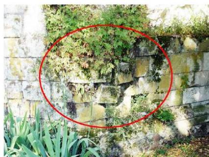
15 - Désorganisation de la partie basse de l'angle Nord-Est, sous l'action du développement de végétaux à système racinaire et des infiltrations de pluvielles entre le parement et le calage interne
